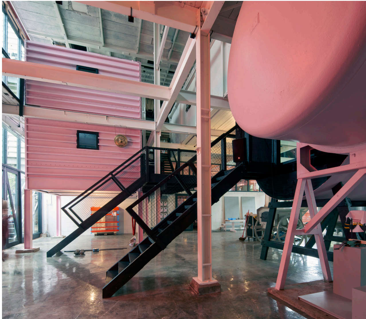
plaatselijk zijn vloerdelen verwijderd en de bestaandes silo's zijn omgevormd zijn tot werkruimtes
