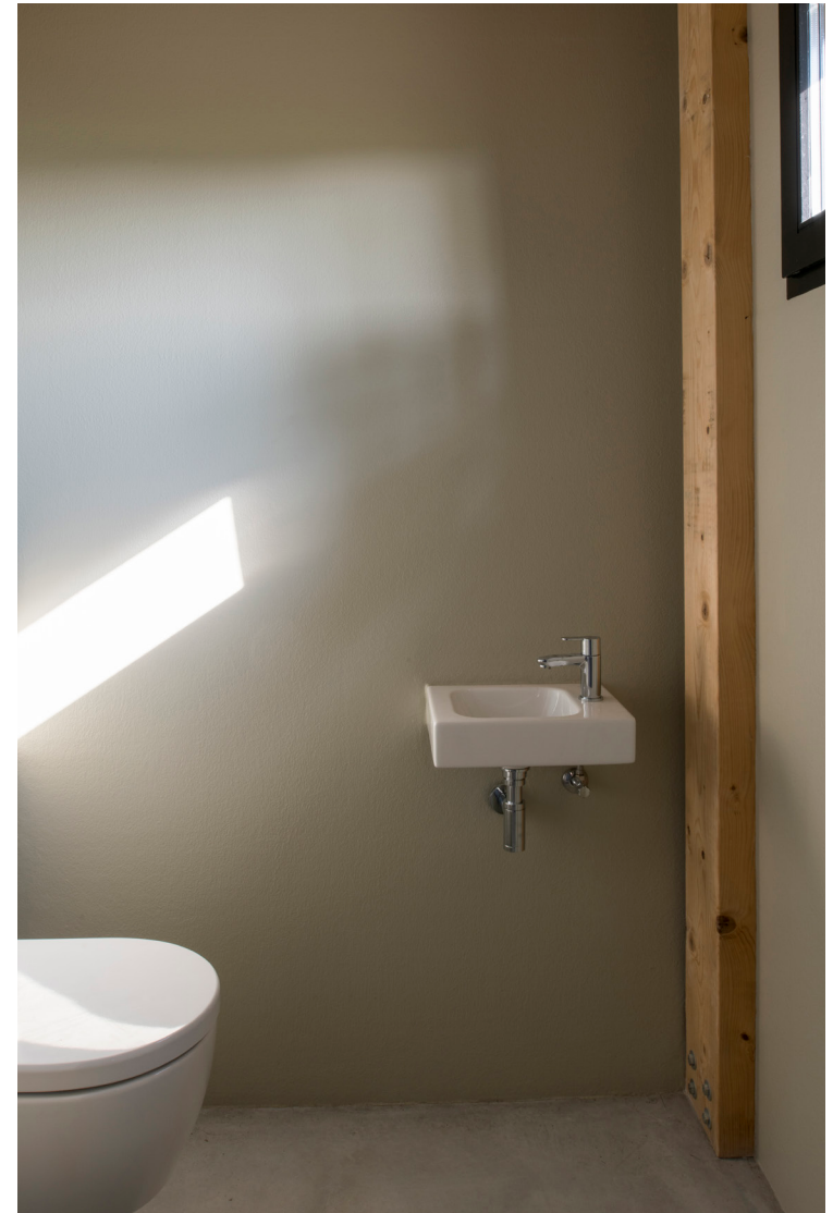
Toilet begane grond
